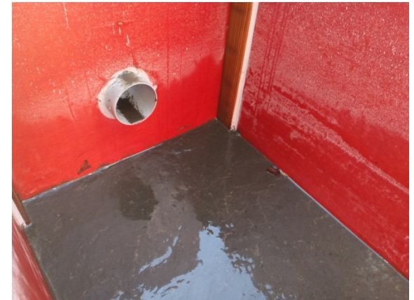
Sorterat sediment i trekammarbrunn
