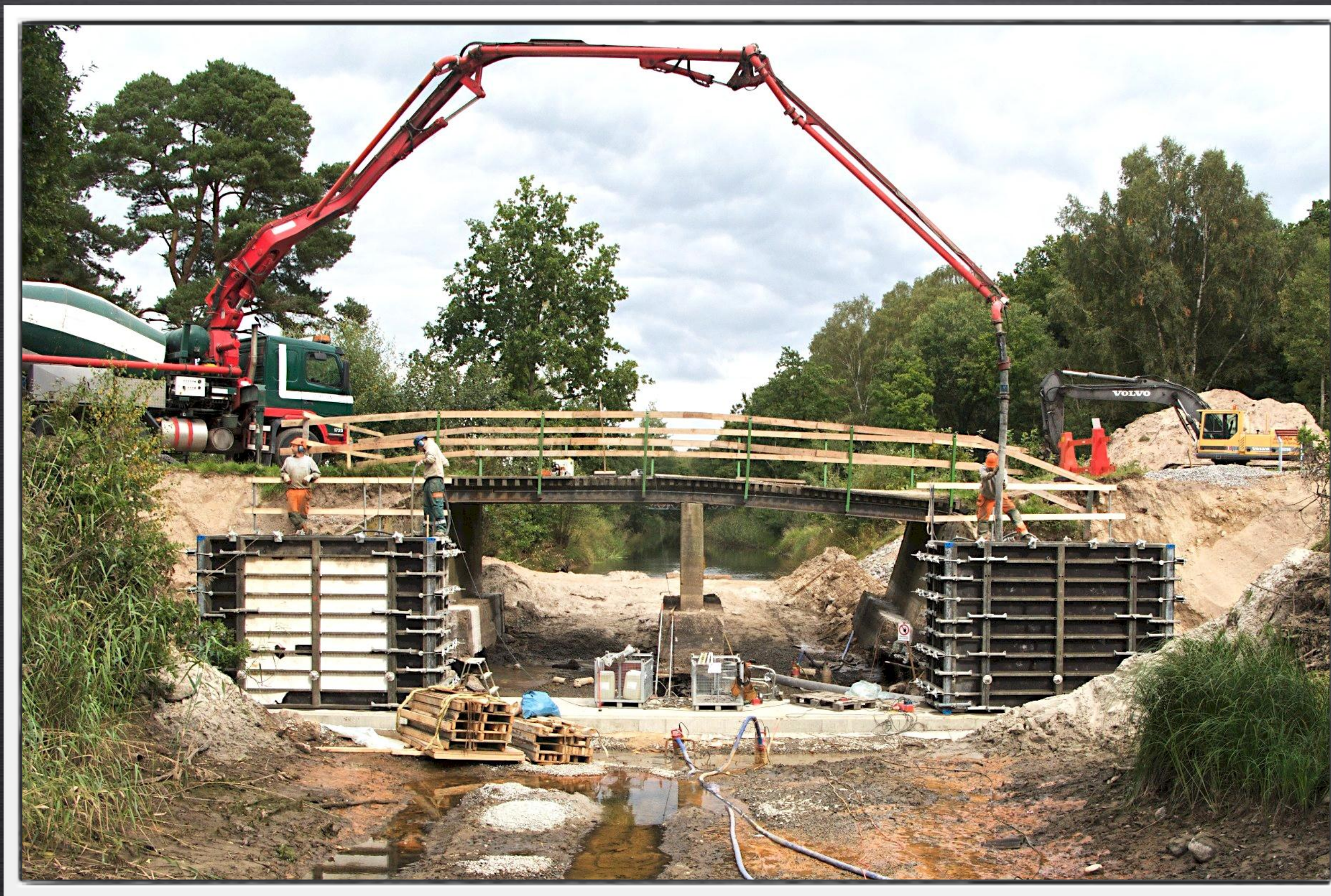
Dämmets plintar gjuts i Alma ån, 2008-09-17
